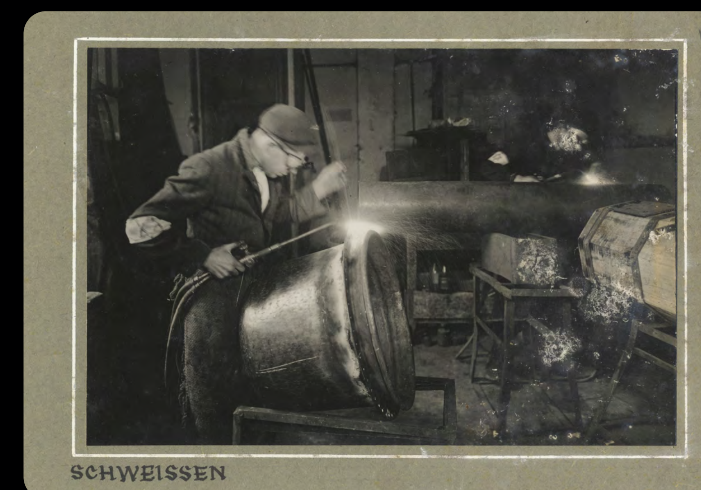
Travail de soudure dans un atelier de fabrication de chaudières du ghetto de Varsovie, vraisemblablement en 1941
